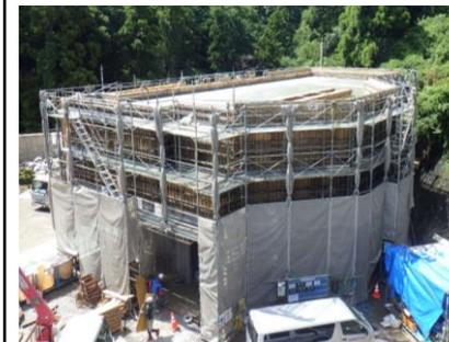
〔管理棟2階 コンクリート打設完了〕
