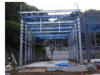
〔プラスチックSY鉄骨工事完了〕
