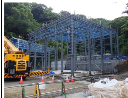
〔サテライトセンター鉄骨工事状況〕
