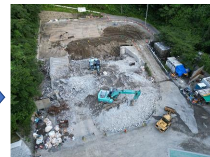
〔炉室基礎解体状況〕
