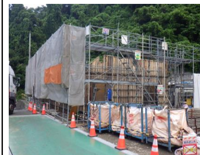
〔管理棟1階壁配筋・型枠状況〕
