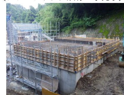
〔休憩棟・車庫棟スラブ配筋完了〕
