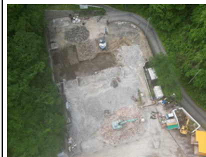
〔炉室解体状況〕
