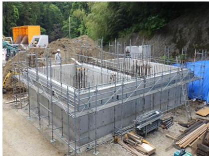
〔休憩棟・車庫棟壁 打設完了〕
