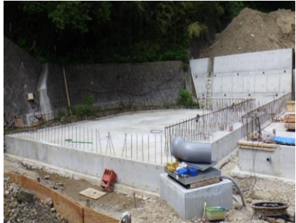
〔プラスチックSY耐圧版 打設完了〕
