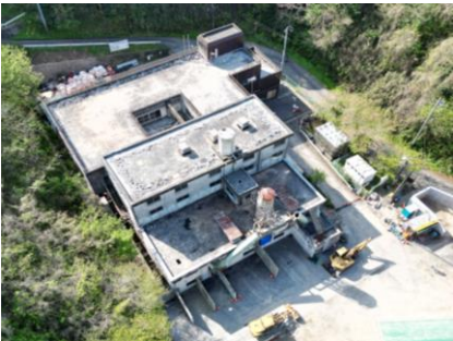
〔ごみ焼却炉・炉室解体前〕
