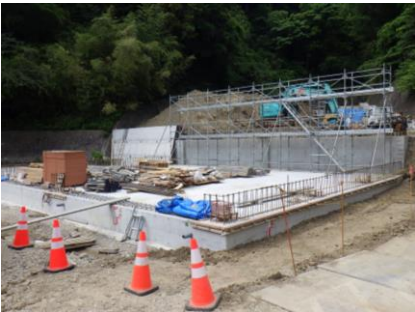
〔サテライトセンター壁 打設完了〕
