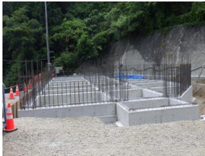
〔管理棟基礎 打設完了〕
