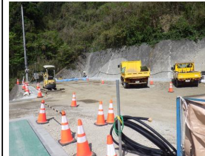
〔管理棟施工前〕
