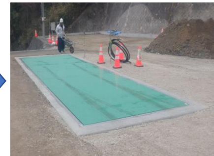
〔ごみ計量機据付完了〕
