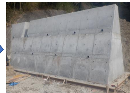
〔擁壁A脱型完了〕
