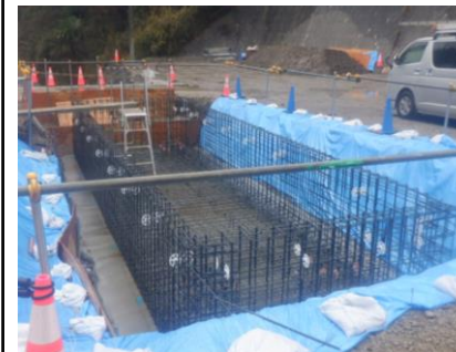
〔ごみ計量機配筋完了〕
