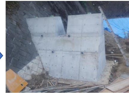
〔擁壁B脱型完了〕
