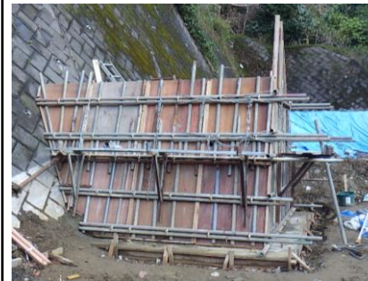
〔擁壁B施工状況〕
