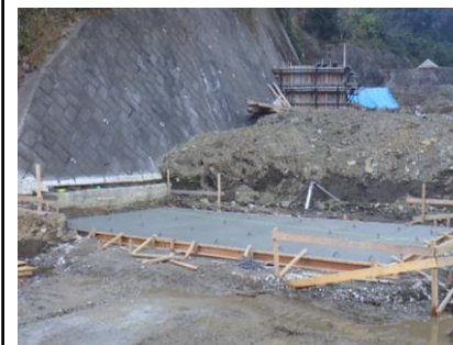
〔擁壁A設置前〕
