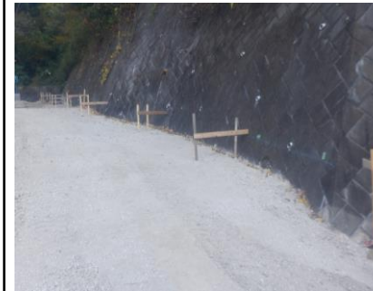
〔雨水側溝設置前〕
