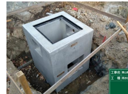
〔集水柵設置完了〕
