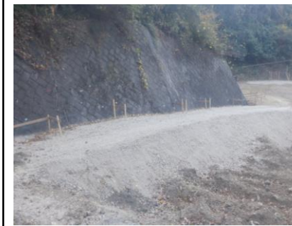
〔雨水側溝設置前〕
