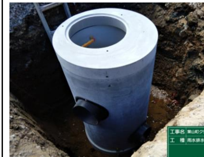
〔人孔柵設置完了〕
