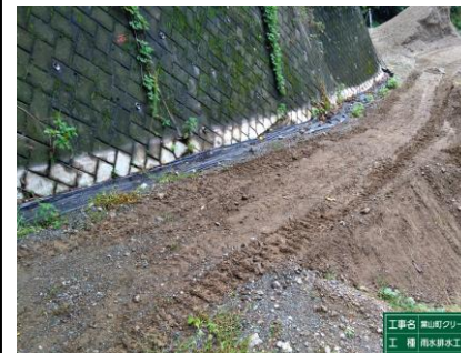
〔雨水側溝施工前〕
