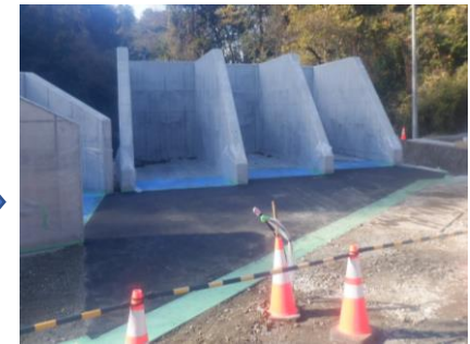
〔As舗装施工完了〕
