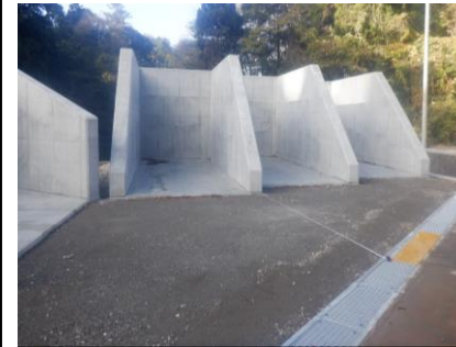
〔As舗装施工前〕
