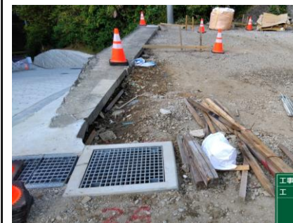
〔雨水側溝設置前〕
