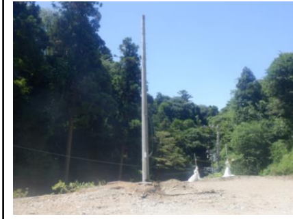
〔既設電柱撤去前〕
