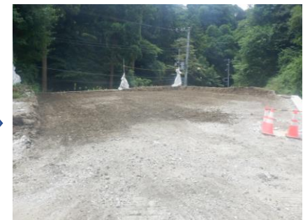
〔ガラス瓶置場解体完了〕
