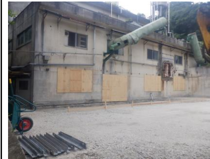
〔仮設ストックヤード擁壁設置前〕
