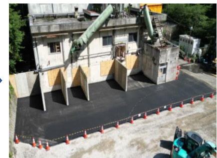
〔仮設ストックヤード舗装完了〕
