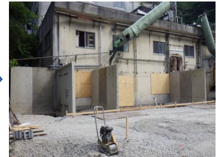
〔仮設ストックヤード擁壁設置完了〕
