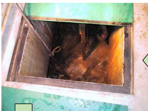
余剰汚泥貯留槽
