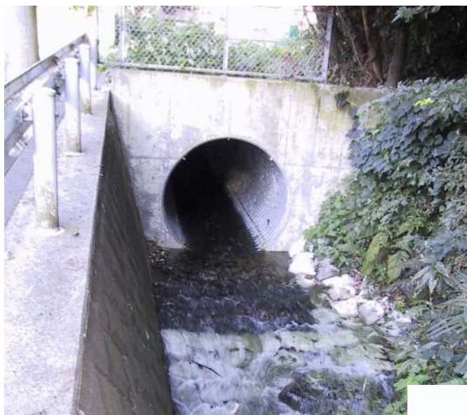
浄化センター放流口
