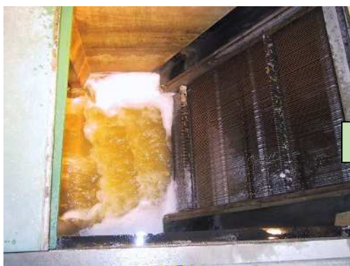
夾雜物除去設備
