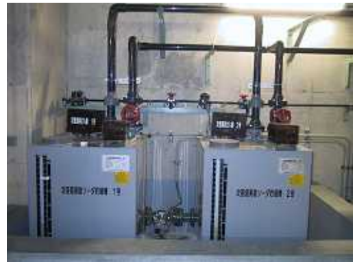
消毒設備 (次亜塩素酸ソーダ貯留槽)
