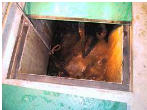
余剰汚泥貯留槽
