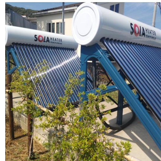
▲屋上菜園に設置した太陽熱温水器 晴天の日は、ほぼガス給湯が不要
