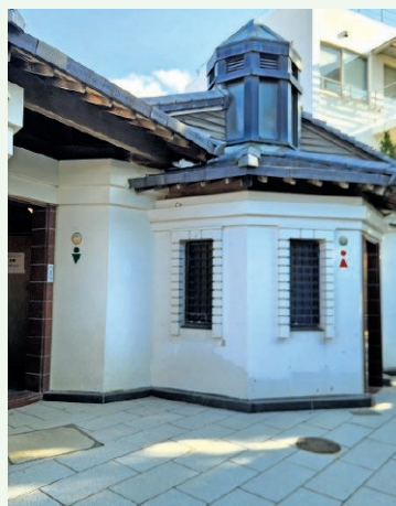
▲ 森戸海岸のみそぎ橋横にあるトイレを改修します
