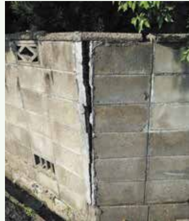
▲ 傾いたブロック塀は倒壊する危険があります
