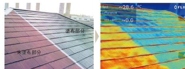
▲外壁も屋根も冷房負荷を抑える遮熱塗装を提案している
