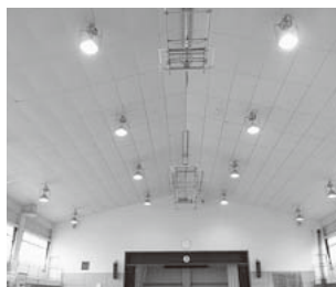
▲ 工事する前の天井
