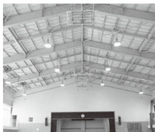
▲ 工事した後の天井
