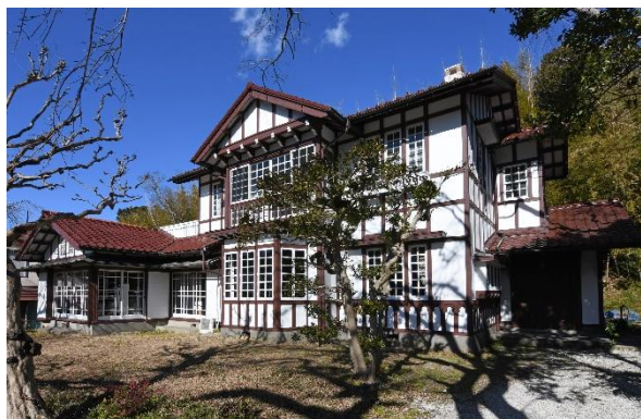
①外観 南東面
