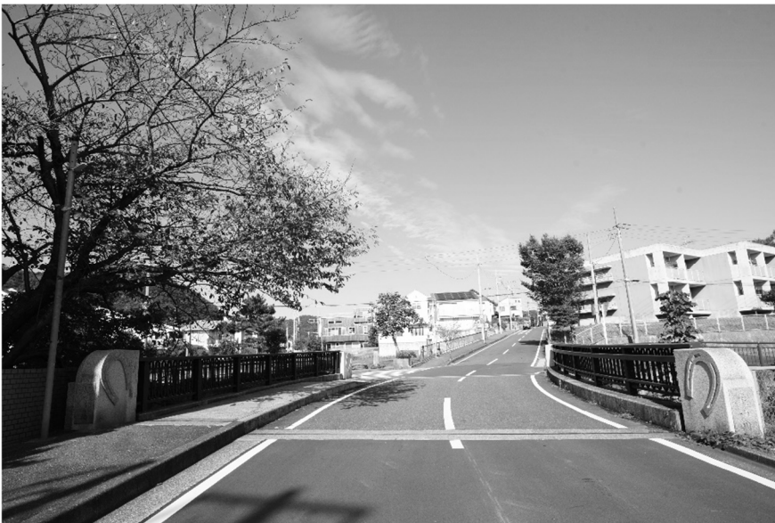
しゅめりょう橋（下山口地区）
