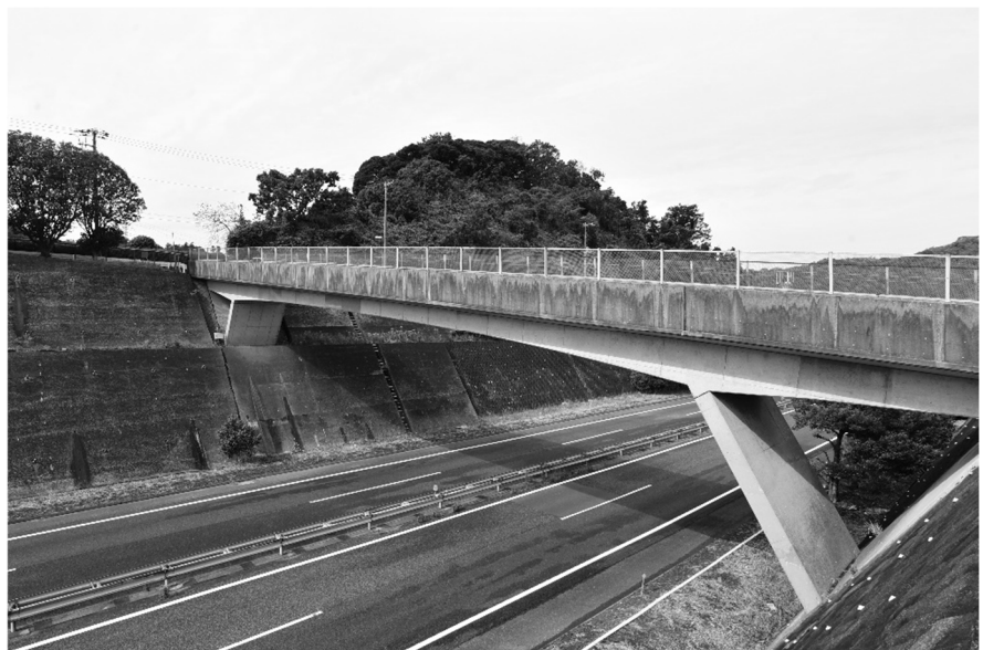
木古庭橋（木古庭地区）
